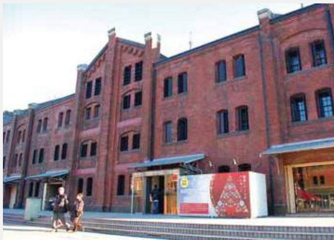
横浜赤レンガ倉庫外観
